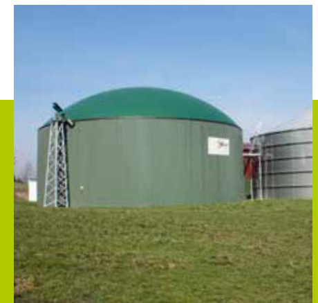
Die Kuppel der Biogasanlage dehnt sich aus, wenn der Fermenter gut mit Gas gefüllt ist.
